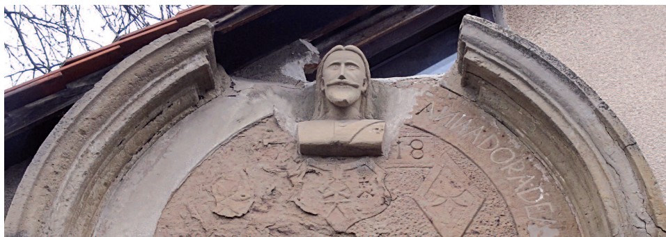
Eingangsgiebel am Haus Hindenburgstr. 20 in Botenheim (Fotovorlage: H. Lichner)
