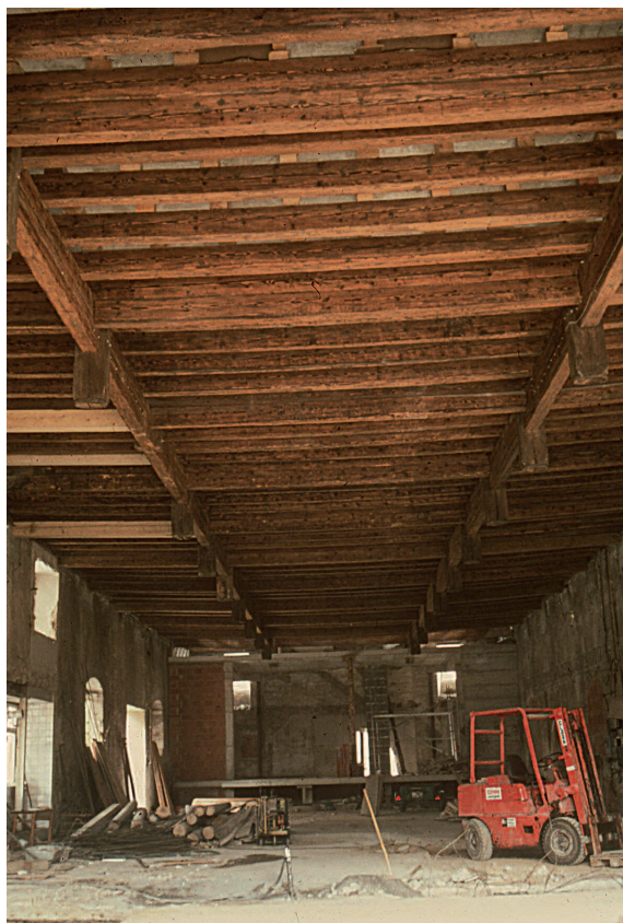
Die Decke des Bürgersaals während des Umbaus (Vorlage: Stadtarchiv Güglingen)
