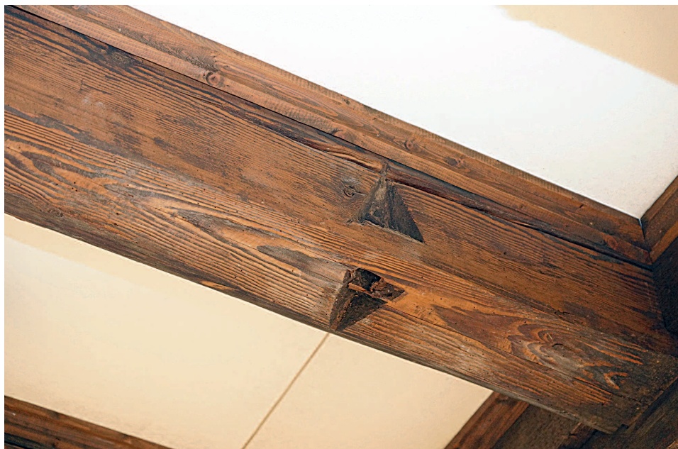
An zahlreichen Balken lassen sich Floßholzspuren erkennen, wie hier die Floßaugen an einem Balken im heutigen Foyer der Herzogskelter (Foto: E. De Gennaro)
