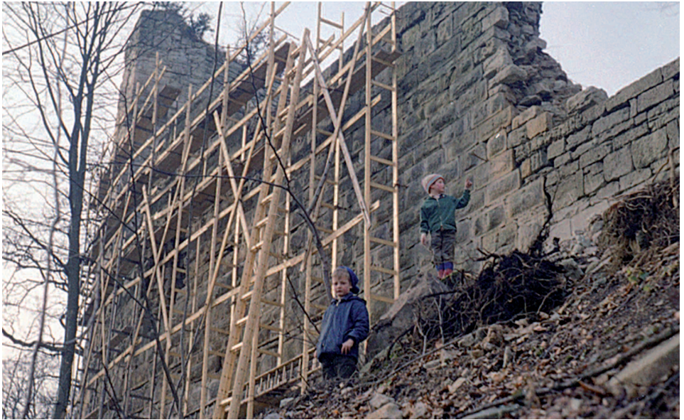
Seit 1900 wurden die der staatlichen Forstverwaltung unterliegenden Burgreste mehrmals gesichert und renoviert. Nicht immer stand die historisch korrekte Wiederherstellung im Vordergrund. Die vorliegende Aufnahme zeigt Renovierungsarbeiten in den Jahren 1965 - 1966 unter dem Forstamtsleiter Ulrich John (1957 bis 1967). Das Bild stammt aus dem Privatbesitz der Familie John. (Vorlage: Stadtarchiv Güglingen)
