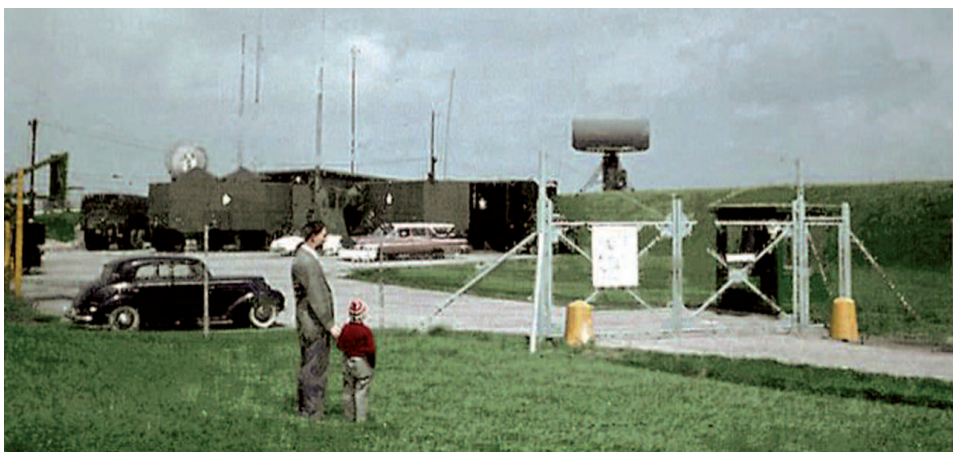
Edwin Stoll mit seinem Sohn vor dem Eingang zum Radarbereich (Bild: Edwin Stoll, 1961)
