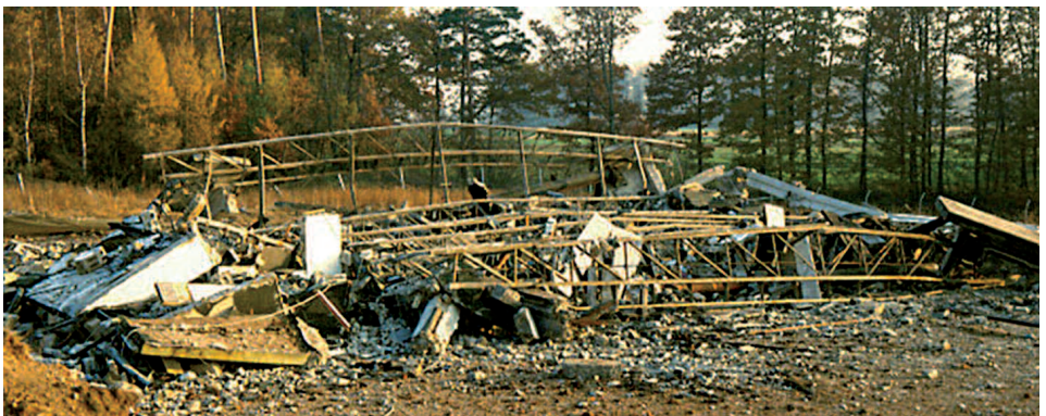
Schrott des Dachgestänges, der von der Halle nach dem Abbruch übrig blieb. (Bild: Thomas Faber, Archiv Thomas Schulz)
