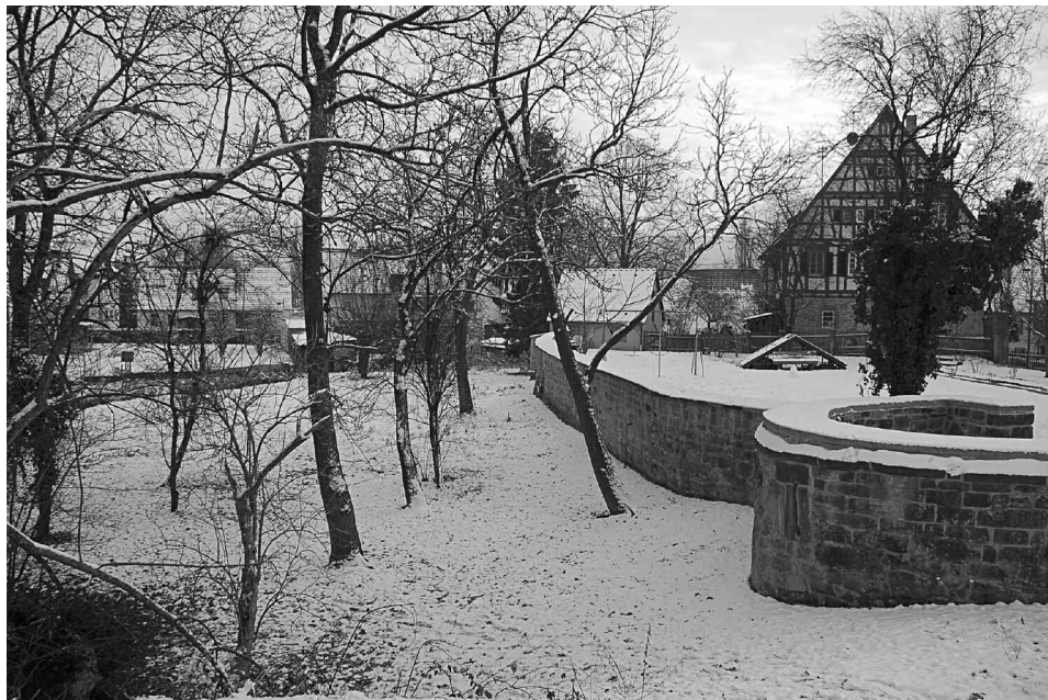
Auch Frost und Schnee kann der nun instand gesetzten Dorfmauer nichts mehr anhaben. Foto W. Stuber, Januar 2010)
