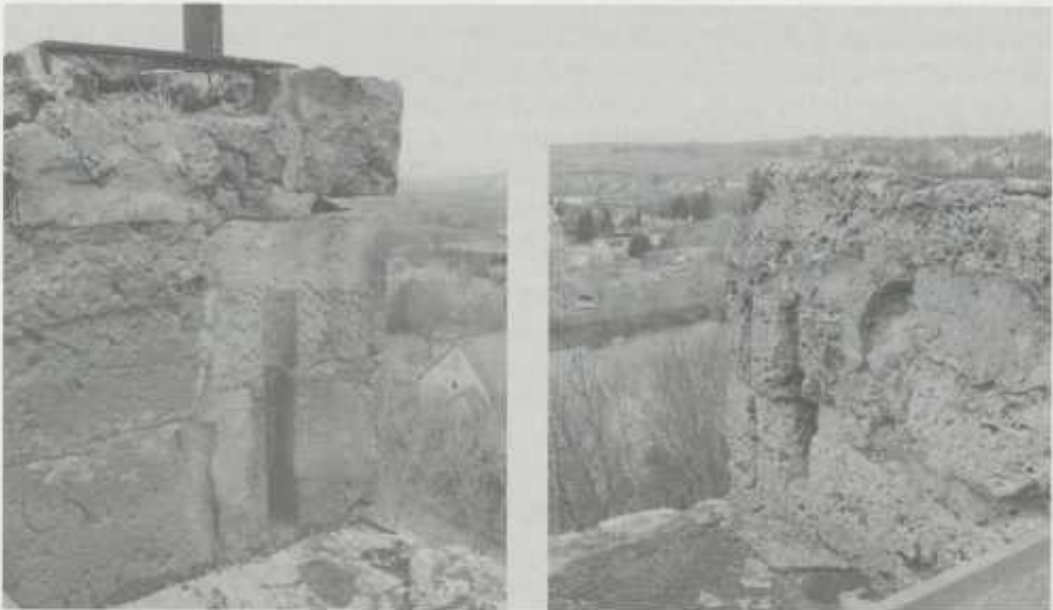
Turmzinnen mit nachträglich eingearbeiteten Prellholznuten.
