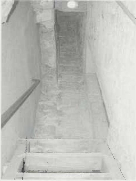
Der zum Treppenaufgang umgenutzte und veränderte Schacht in der Nordmauer des Anbaus.
