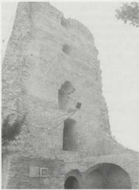
Einzig erhaltene Wand des salierzeitlichen Wohnturms von Dreieichenhain: Innenansicht.
