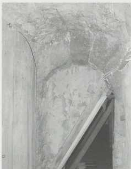
Hocheingang des Lauffener Turmes von innen.
