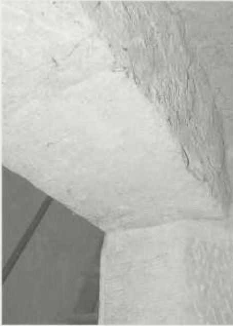
Scharriertes Türgewände des heutigen Zugangs zum Bergfried.
