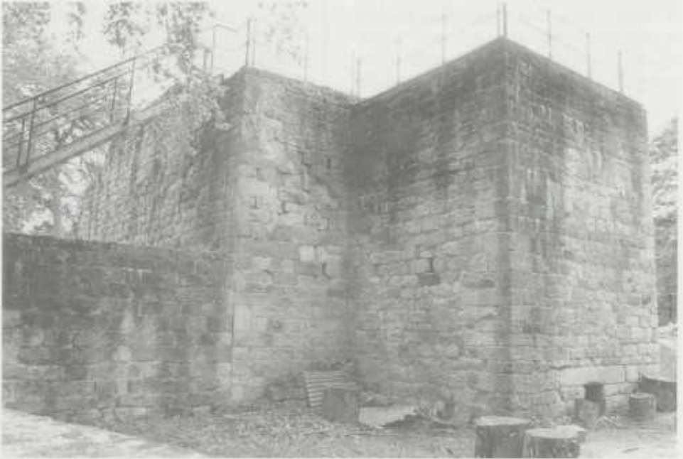
Anbau des Schlüssel-Wohnturms mit Entleerungsöffnung zu ebener Erde.
