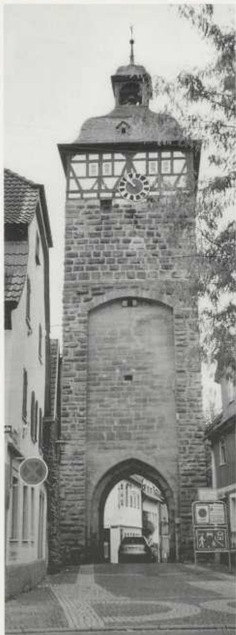
Abb. 2 – Oberes Tor, Feldseite. In dem tiefer liegenden Feld mit glattem Quadermauerwerk lief ein Fallgitter in seitlichen Führungsnuten. Von seiner Zugvorrichtung ist oben im Bogenscheitel noch die Öffnung für das Zugseil zu sehen. Über den mittelalterlichen oberen Abschluß des Turmes ist nichts bekannt. Das zweiflügelige Tor schlug nach innen auf. Foto W.-G. Fleck
