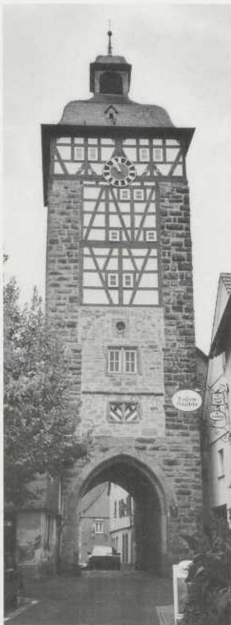
Abb. 3 – Oberes Tor, Innenseite. Auch hier war ein nach innen aufschlagendes Tor vorhanden. Deutlich zu sehen ist, daß der Turm nach innen offen war. Die einzelnen Stockwerke hatten nur Holzbrüstungen. Im Fall einer Eroberung hatten die Feinde keine Möglichkeit, sich gegen die Stadt hin darin zu verschanzen. Foto W.-G. Fleck
