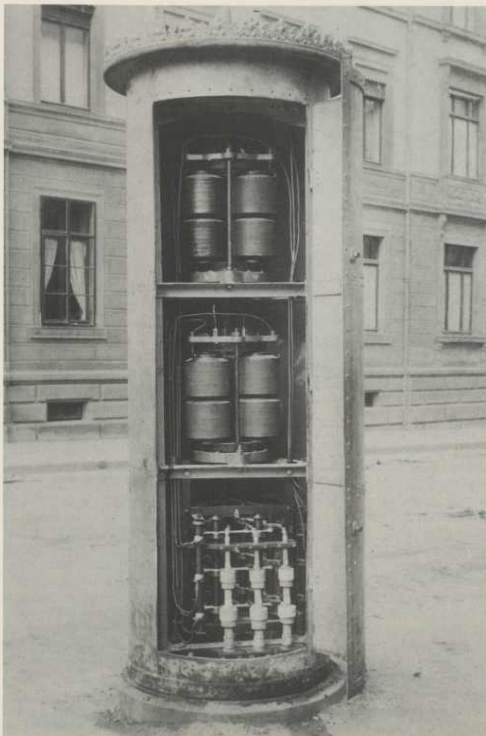
Transformatorstation für Drehstrom in Heilbronn in einer Litfaßsäule.
