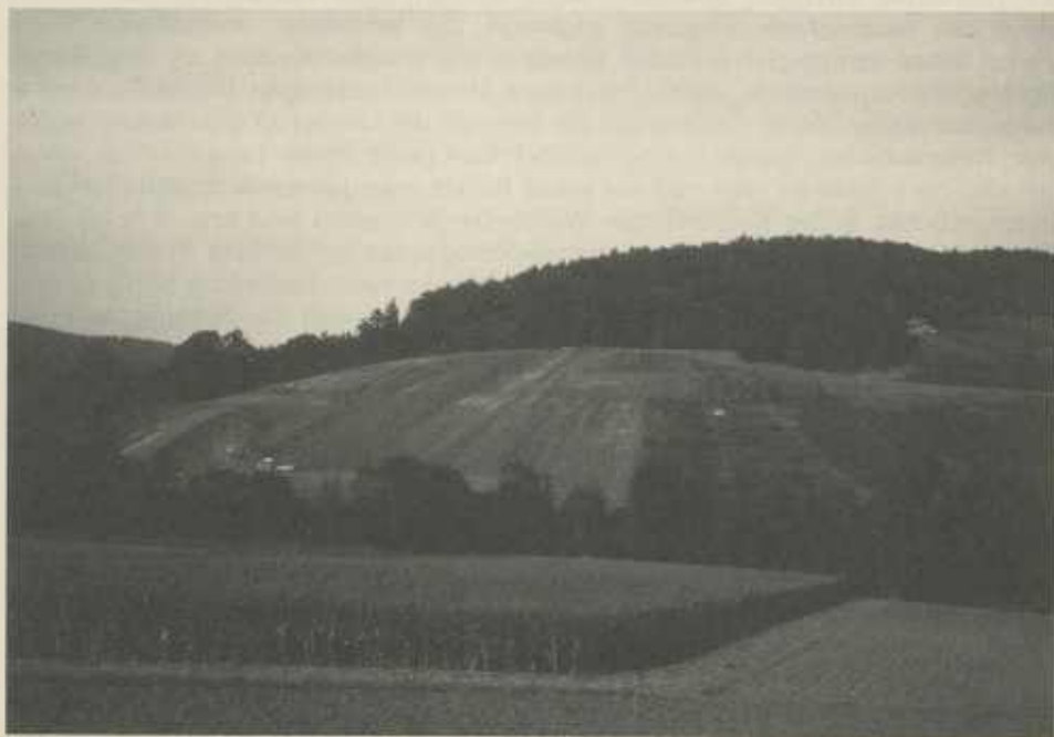
Brunnhälde kurz nach Beginn der Erd- und Planierungsarbeiten im Herbst 1987
