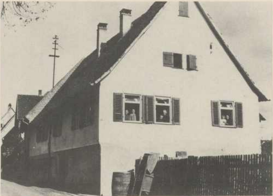
Gebäude Hauptstraße 18 gegenüber der Kirche, um 1926, abgebrochen 1975
