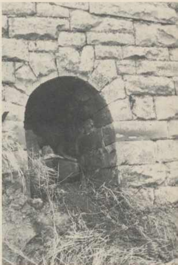
Eingang eines Mergelstollens mit eingebrochenem Gang
