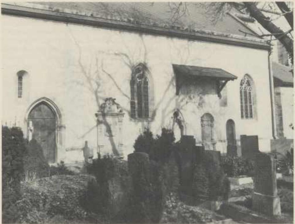
Johanniskirche. Südliche Langhauswand mit romanischen und spätgotischen Öffnungen. Foto: Dürr
