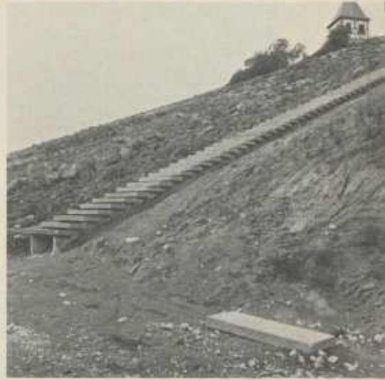
Abb. 27: Die neue Kapuzinerstapel im Bau, Juli 1977
