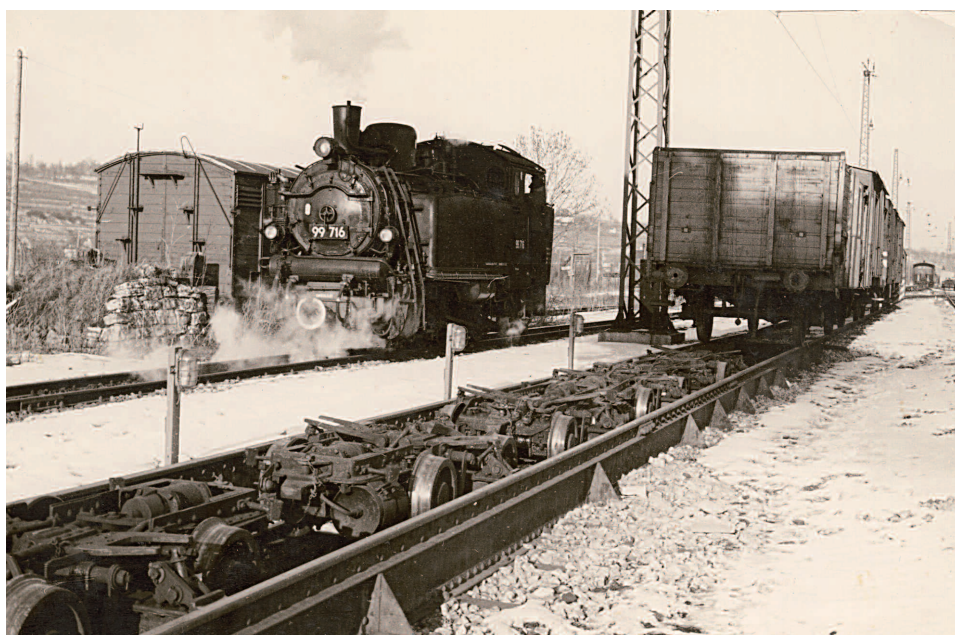
Anfang März 1963 werden auf der Rollschemelgrube in Lauffen am Neckar normalspurige Güterwagen für die Weiterfahrt mit 99 716 ins Zabergäu bereitgestellt. (Foto: Bundesbahndirektion Stuttgart/Willi Doh)
