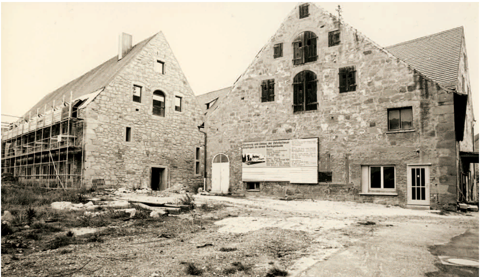
Die Zehntscheuer und das Bandhaus während des Umbaus (Vorlage: Stadtarchiv Güglingen)
