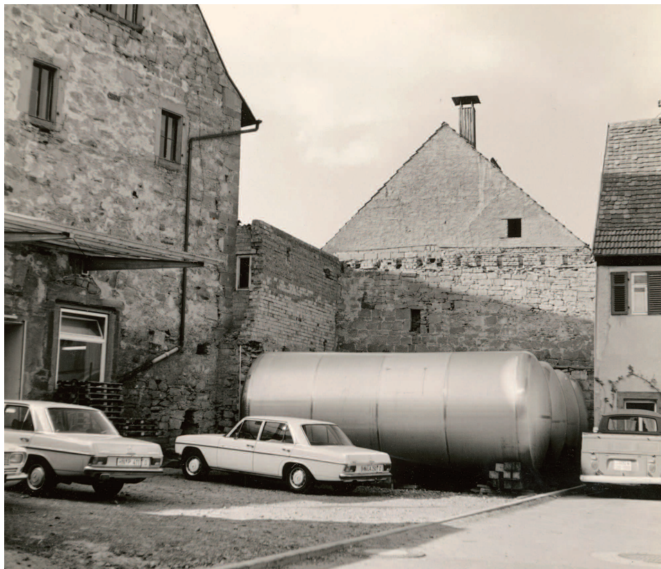
Große Tanks an der nordöstlichen Ecke des Areals. An der Ecke dahinter fanden sich Reste der alten Stadtmauer, die in das Sanierungskonzept integriert wurden. (Foto: Dörr, Vorlage Stadtarchiv Güglingen)
