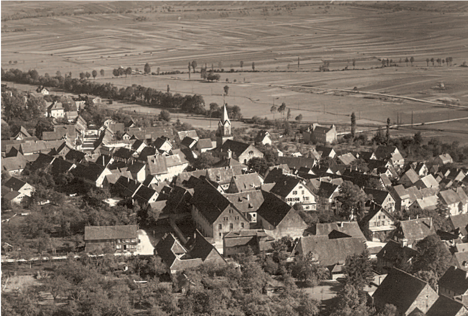
Die Luftbildaufnahme aus dem Jahr 1936 lassen im Vordergrund die historischen Keltergebäude erkennen. (Vorlage: Stadtarchiv Güglingen)
