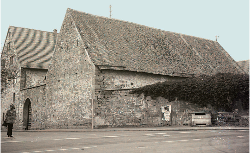
Die Kelter mit Zehntscheuer vor der Sanierung (Foto: Dörr, Vorlage Stadtarchiv Güglingen)
