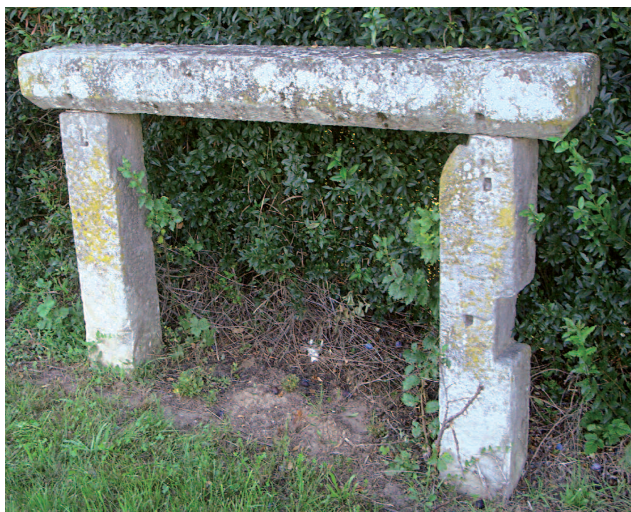
Das translozierte Gruegstatt-Relikt am Holzweg von Meimsheim zum Michaelsberg. Am rechten Pfosten ist die Aussparung für das frühere niedrigere Bauteil deutlich sichtbar. Die Eisenklammern der drei Steine sind durch Zementmörtel ersetzt worden.
