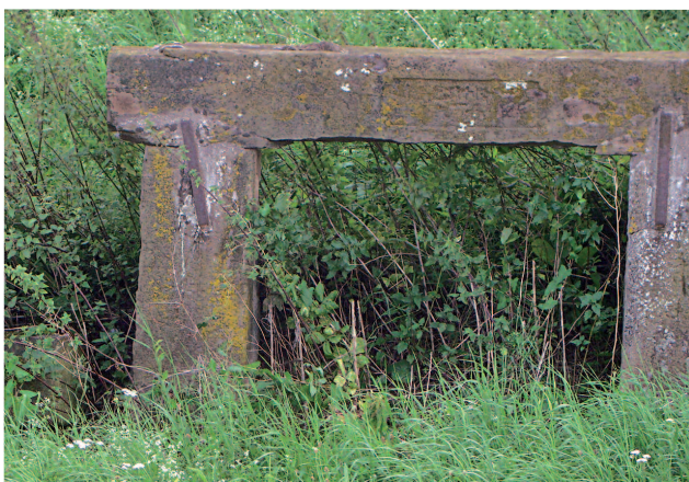
Eine vergessene Gruegstatt an der Straße von Brackenheim nach Stockheim. Das niedrigere Sturzteil liegt im Rain unter hohen Brennesseln, am höheren Sturz ist die Inschrift mit der Jahreszahl kaum noch zu lesen.
