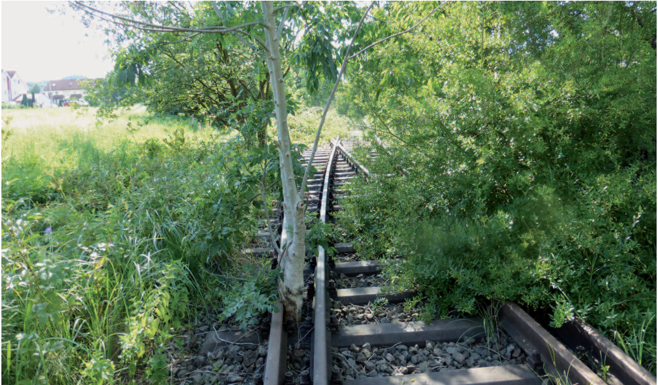
Abb. 1: Wohin geht der Weg? Eine schleichende Verwachsung der Gleisanlagen führt zur Degradierung eines wertvollen Lebensraumtyps. Alte Schienen auf Höhe des ehemaligen Bahnhofes Pfaffenhofen; Foto S. Hammel, 01.08.2014.
