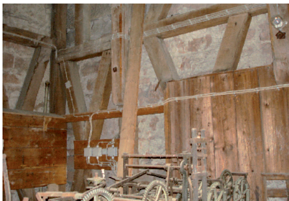
Fachwerkkonstruktion im Turminnern (Foto: Von der Kall)
