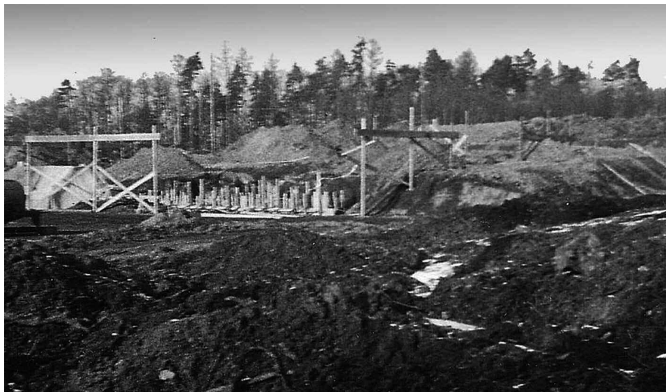
Bauarbeiten im Jahr 1959 (Bild: Günter Walter)
