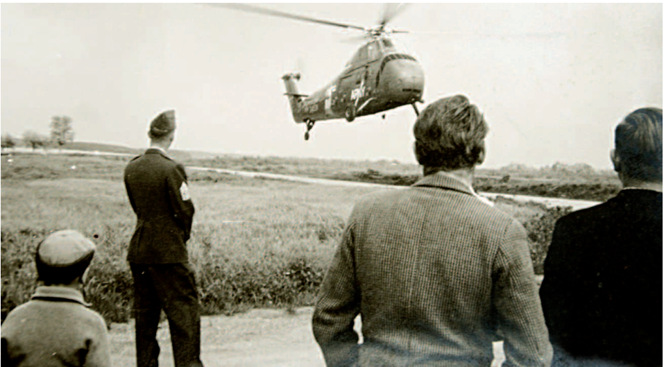
Landung eines Sikorsky H34-Hubschraubers auf der Zufahrtsstraße in der Nähe des Wachhäuschens während der Bauarbeiten an der Basis– damals immer wieder ein lokales Highlight mit entsprechender Beachtung der Anwohner. Dem U.S. Army-Sergeant macht dies nichts aus. Die Baumreihe im Hintergrund säumt die Straße nach Haberschlacht und Niederhofen. (Bild: Hermann Sommer, 1958)
