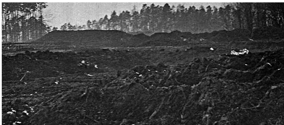
Erdarbeiten für die Abschussbasis (Bild: Günter Walter, 1959)
