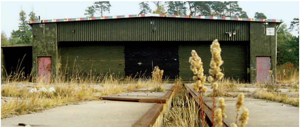
Die Raketenhalle der Abschussgruppe B vor dem Abriss. Aus dem Kabelkanal, früher unter dem Transportgleis, wachsen längst Sträucher (Bild: Thomas Faber, Archiv Thomas Schulz)
