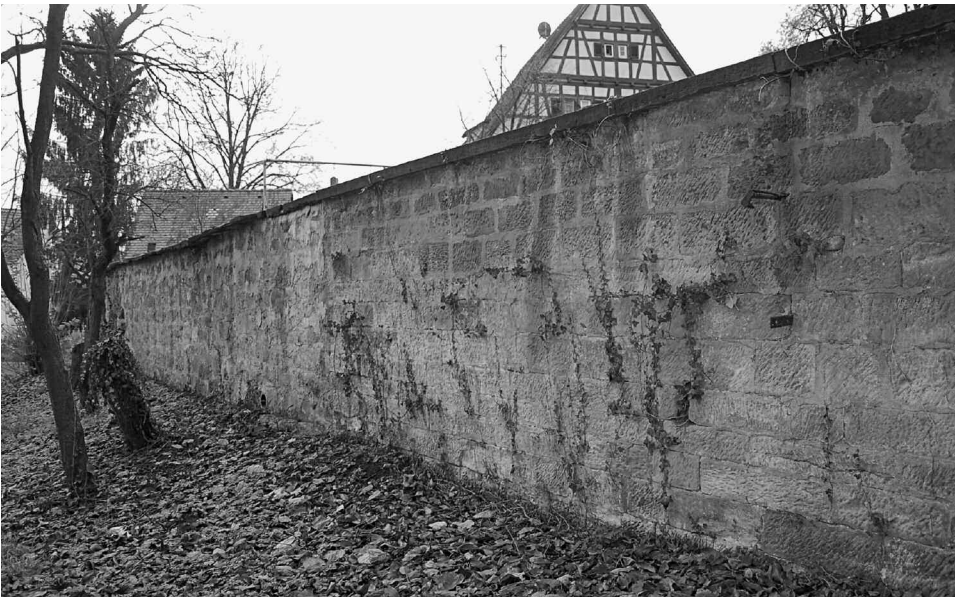
Großes Stück der erhaltenen Fleckenmauer im Bereich Pfarrgarten (Foto W. Stuber, Nov. 2007)
