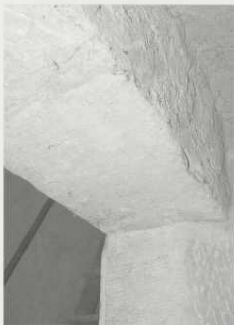
Scharriertes Türgewände des heutigen Zugangs zum Bergfried.
