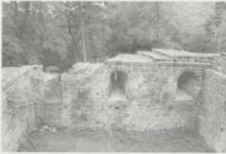
Erhaltenes Erdgeschoss des Schlössel-Wohnturms. Die sich außen zu schmalen Schlitzfenstern verjüngenden Öffnungen sind innen mit kleinteiligen Rundbögen überwölbt.
