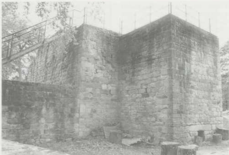
Anbau des Schlössel-Wohnturms mit Entleerungsöffnung zu ebener Erde.
