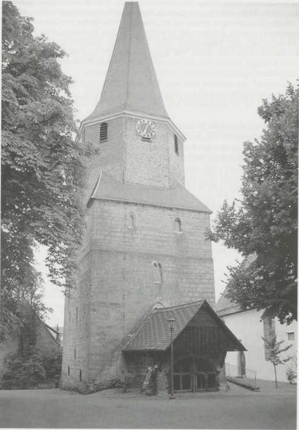
Abb. 7: ehemaliger Wohn- heute Kirchturm in Derdingen, Foto W. Eiermann
