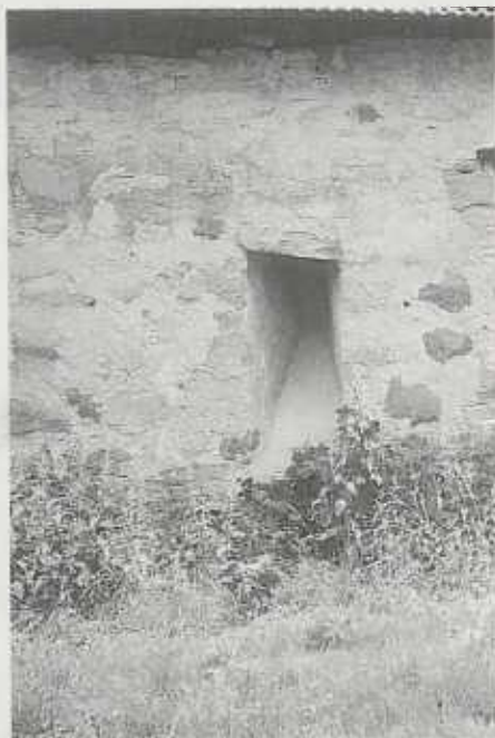
Stocksberg: Bergfriedendecke nach Ringmauerabbruch; Senkscharte der Grabenwehr der Vorburg
