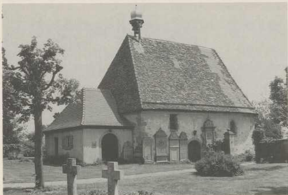
Die Kapelle um 1990 vor der Renovierung mit den Epitaphien
