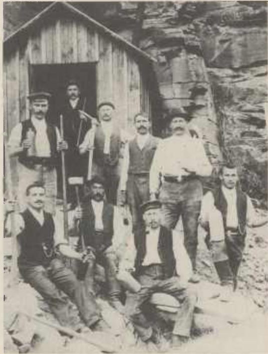
Beim Brechen von Steinen für den Straßenbau am Steinbruch gegen Schwaigern, 1912
