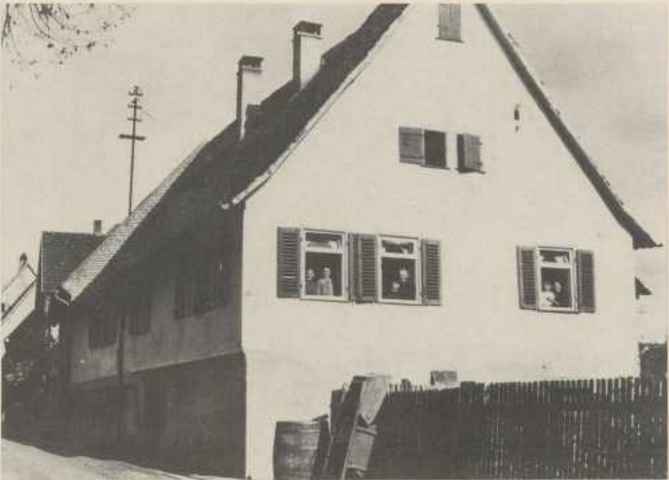
Gebäude Hauptstraße 18 gegenüber der Kirche, um 1926, abgebrochen 1975
