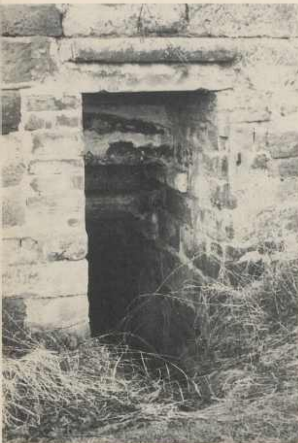
Eingang des Mergelstollens in Brackenheim-Stockheim
