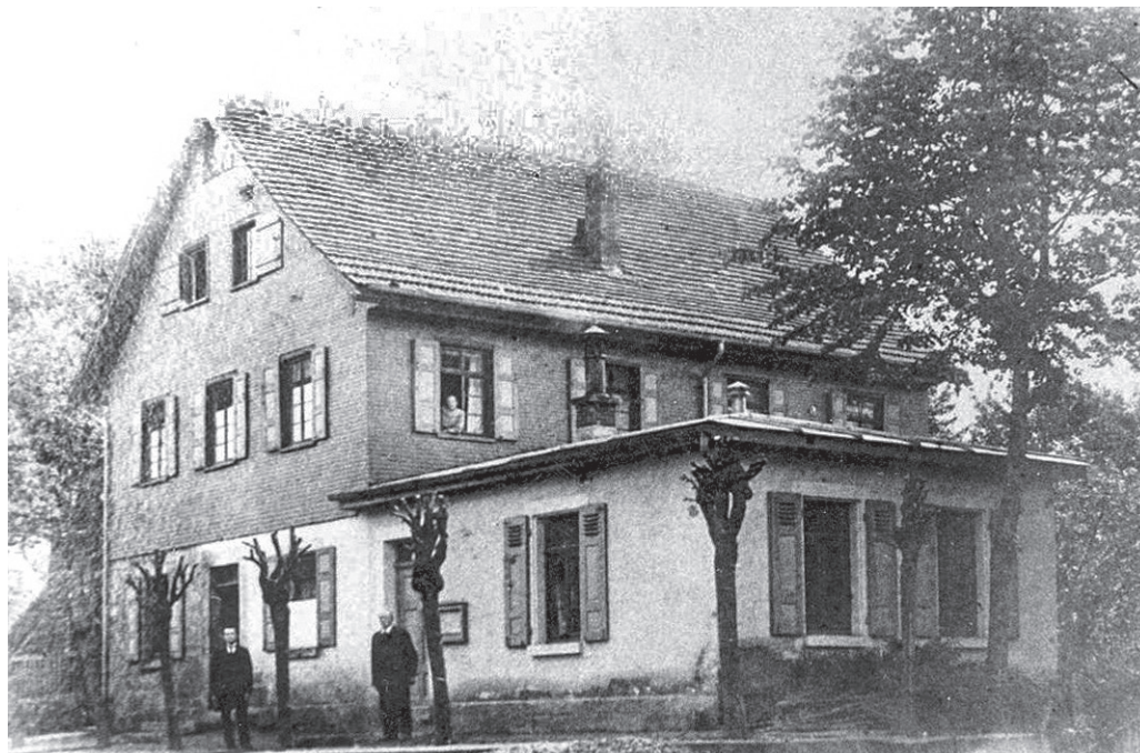
Das 1842 erbaute Schul- und Rathaus mit dem Arrestanbau von 1882.
