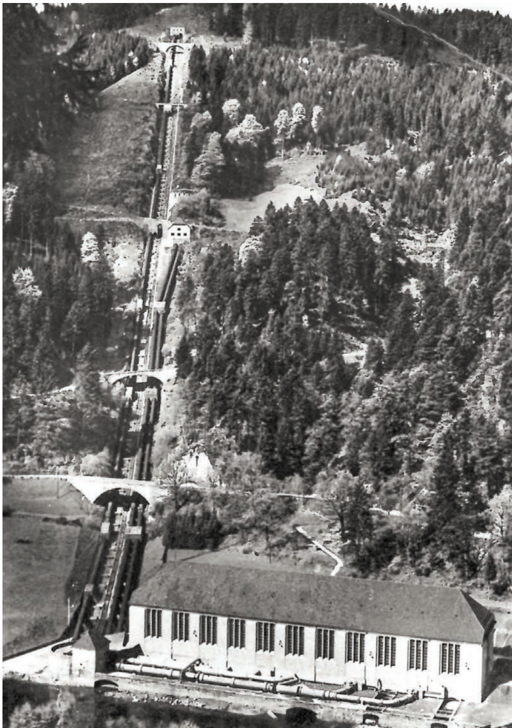
Das Murgkraftwerk bei Forbach – auf dem Hang gegenüber befand sich Pfizenmaiers Zugstellung.
