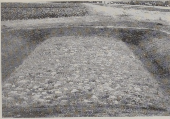
Abb. 5: Restaurierte römische Straße bei Kornwestheim.
