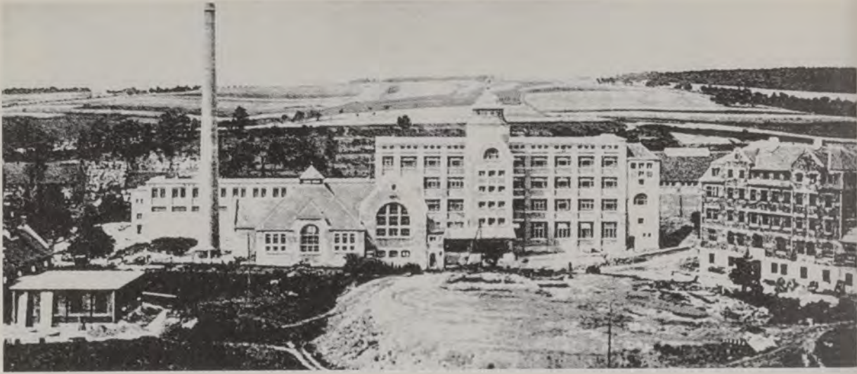
Bild 18: Der erste Abschnitt des Steinbacher Werks nach seiner Fertigstellung am 1.7.1907. Rechts der Marienheim-Rohbau, ein Wohnheim mit Versammlungsraum. Links, Färbereierweiterung.
