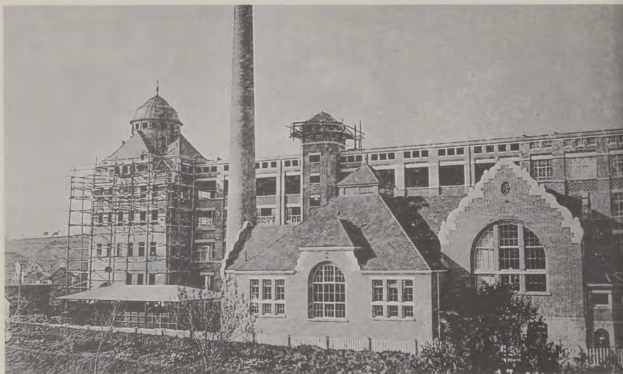
Bild 21: Der Bau des zweiten Abschnitts der neuen Fabrik. Aufnahme von Süden vom 27.10.1910.
