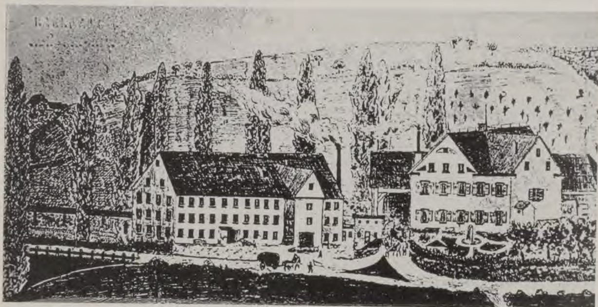
Bild 6: Die Spinnerei Adolff um 1865 (Lageplan siehe oben). Vorn die Straße von Steinbach (links) nach Backnang (rechts) mit Abzweigung zur Walke. Hinten von links: Hölzerne Wasserrinne, Spinnerei mit Lokomobilraum, Waschhaus und Wohnhaus mit Ziergarten. Dahinter: Chaisen-Remise (Pferdekutschen-Unterstand), Wollmagazin und Scheuer. Der Lohkässtand ist verdeckt.
