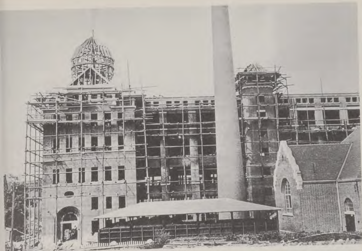
Bild 20: Diese Aufnahme ist zur Zeit des Richtfestes am Rohbau des zweiten Bauabschnitts vom Werk 2, am 30. 8. 1910 entstanden. Sie beweist die Schnelligkeit bei damaligen Bauvorhaben. Die Ausschreibung wurde erst am 4. 4. 1910 im Murrthal-Boten veröffentlicht.
