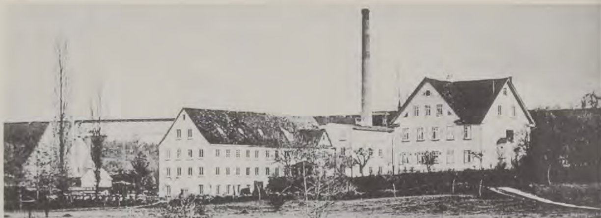
Bild 14: Die Spinnerei Adolff um 1883. Links das alte Spinnereigebäude im Zustand von 1865. In der Mitte die 1876 errichtete Gebäudegruppe, z. Zt. Färberei/Wolferei/Haspelei/Versand, dahinter Kessel- und Maschinenhaus mit Schornstein. Rechts das Wohn- und Bürogebäude im Endzustand, wie es ähnlich noch heute erhalten ist.
