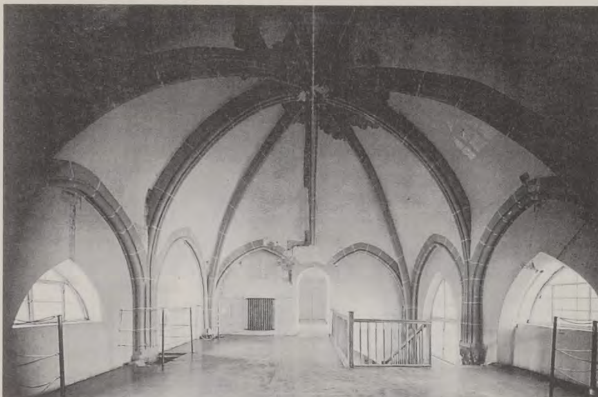
Abb. 15: Stadtturm. Zweites Obergeschoß des Chores. Nach Westen.
