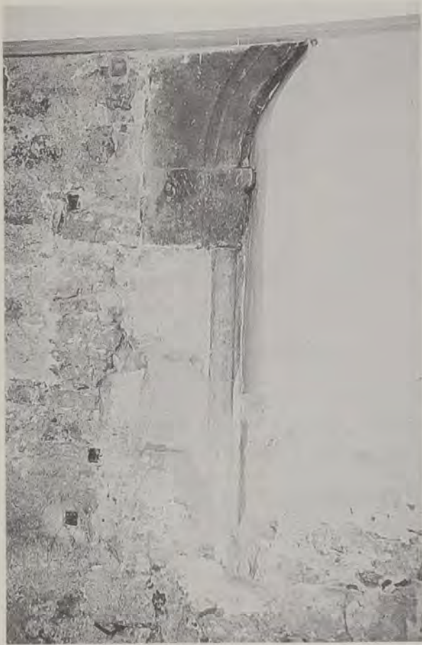
Abb. 18: Turmschulhaus. Rundbogenfragment in der Erdgeschoß-Ostwand des nördlichen Schulzimmers.
