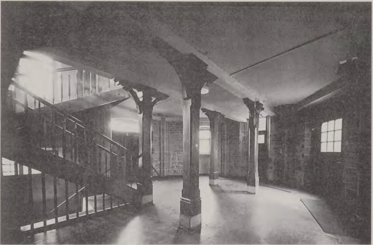
Abb. 13: Stadtturm. Erstes Obergeschoß des Chores. Nach Nordosten.
