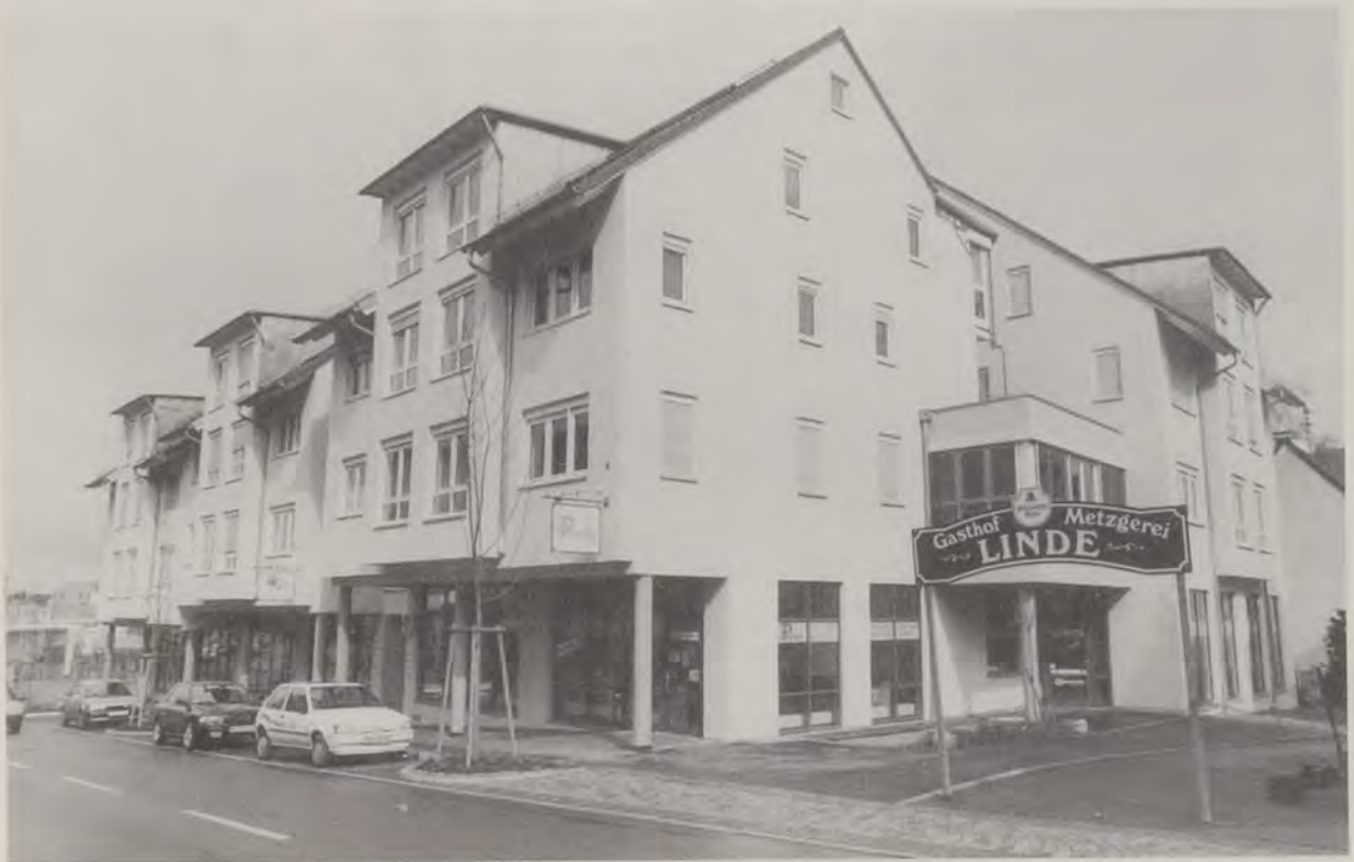
Bei der Einweihung des Wohn- und Geschäftshauses „Blumenarkaden“ in der Blumenstraße 11 wird von einem top-modernen Gebäude mit pfiffigen Detaillösungen gesprochen.
