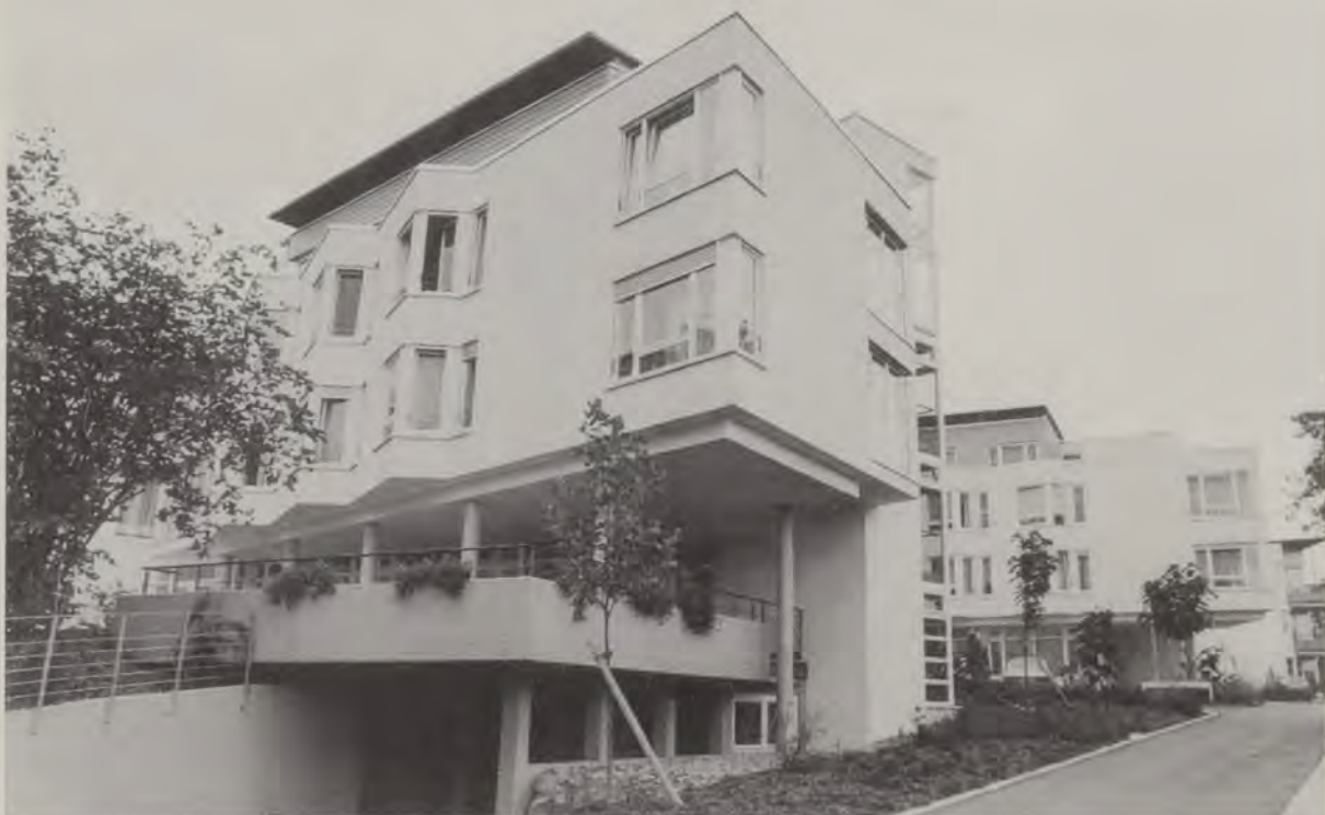
Der Neubautrakt des Pflagestifts Bürgerheim wird von den Experten der Architektenkammer Baden-Württemberg im Rahmen ihres Wettbewerbs „Beispielhaftes Bauen 1896 bis 1996 im Rems-Murr-Kreis“ ausgezeichnet.
