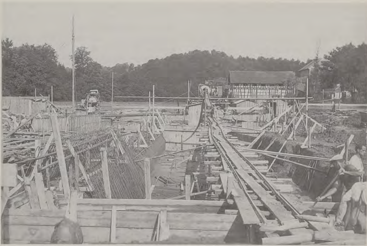
Bau der ersten Kläranlage in Neuschöntal 1935.
