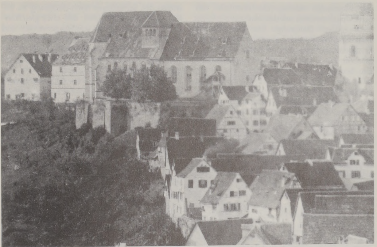
Das älteste Foto des Schickhardt-Schlusses aus dem Jahre 1874. Zwar ist hinter dem Chor der Stiftskirche nur ein Teil des Schlusses sichtbar, aber es ist klar der Bauzustand vor den Umbauten von 1875/77 zu erkennen. Insbesondere waren wesentlich weniger Fenster vorhanden als im 17. Jahrhundert und – wieder – nach 1875/77.
