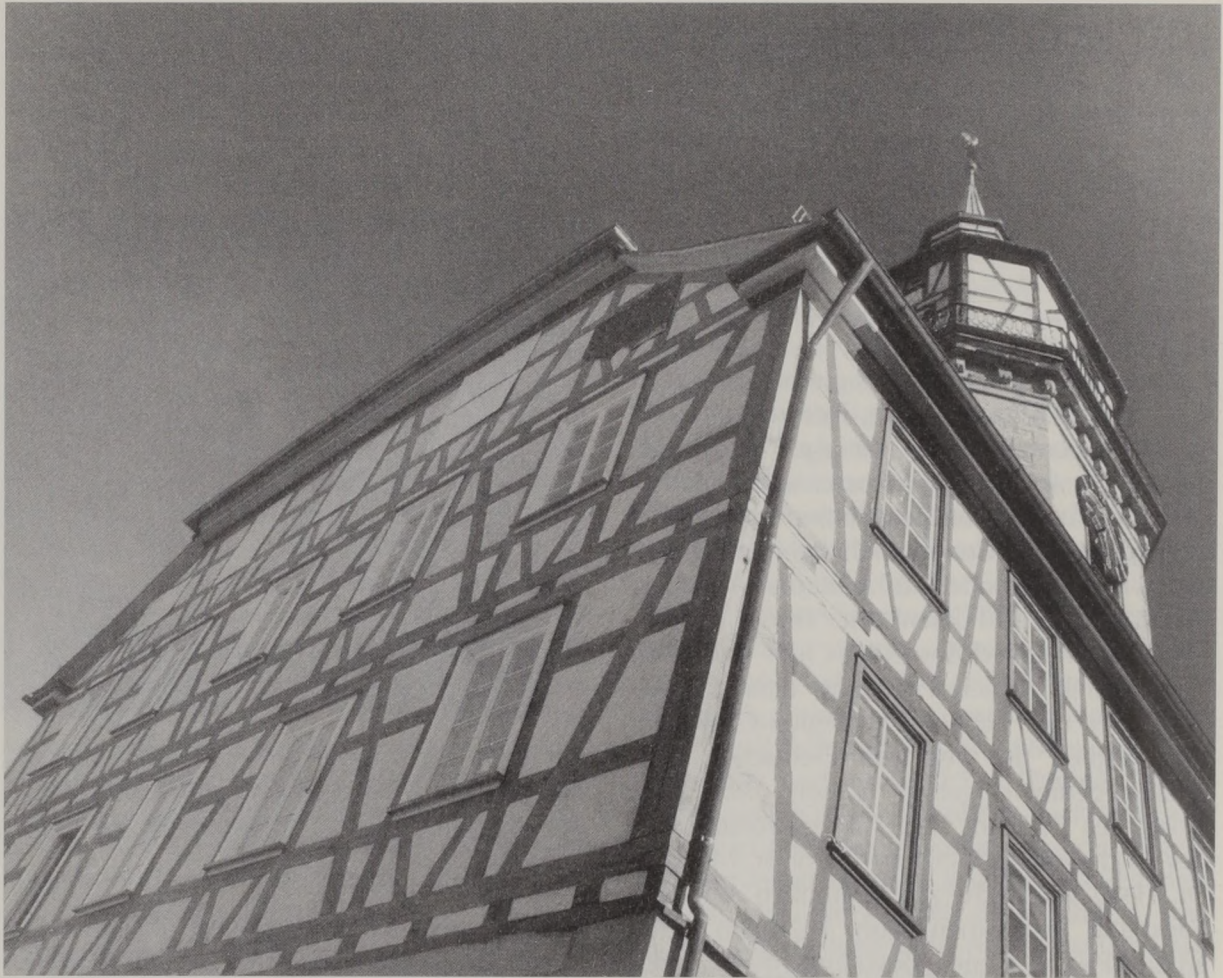
Das historische Fachwerk des Turmschulhauses wurde durch neues Holzwerk ersetzt.
