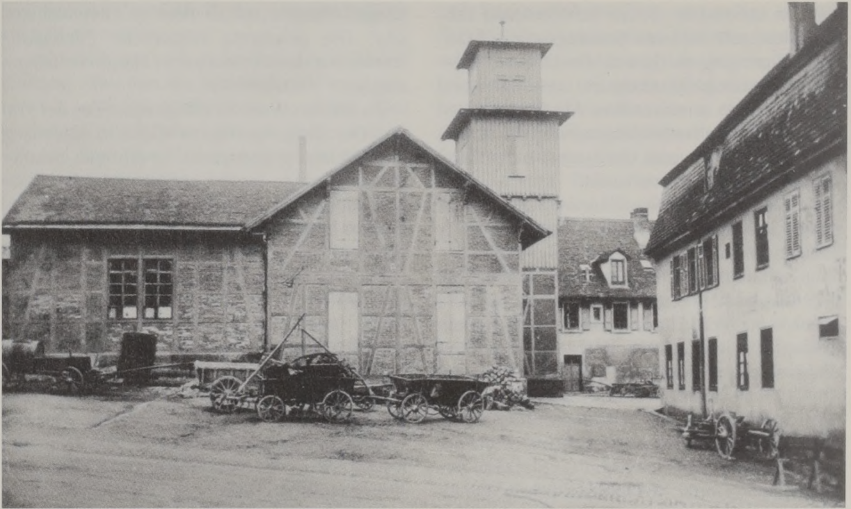
Turnhalle und Feuerspritzenremise auf dem heutigen Adenauerplatz (Aufnahme um 1920).
