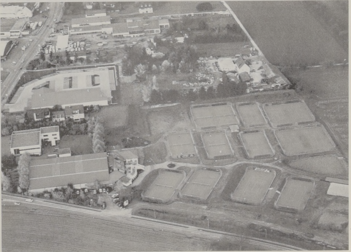
Neue Freiluftanlage der TSG Backnang Tennis an der Weissacher Straße mit 14 Plätzen.
