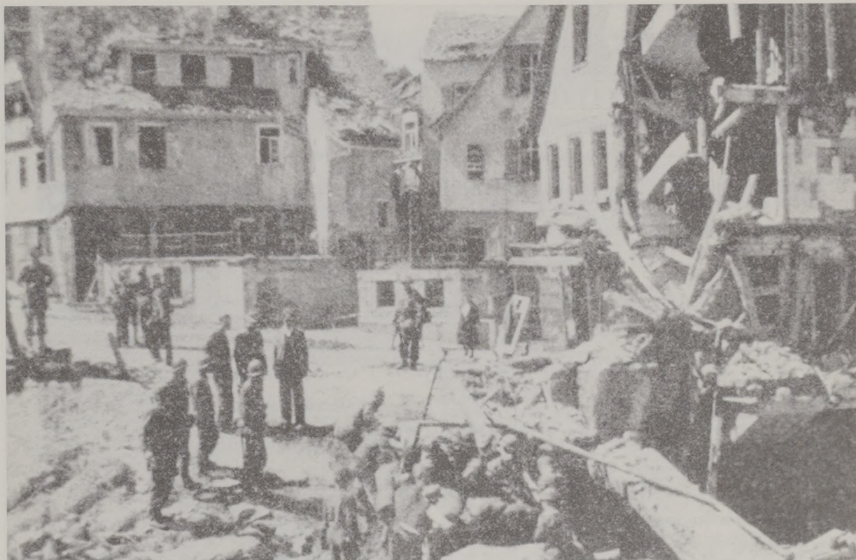
Die Sulzbacher Brücke war nach der Sprengung durch die deutsche Wehrmacht nur nach unten abgesackt und konnte von den amerikanischen Truppen relativ schnell wieder so hergestellt werden, dass sie befahrbar war. Im Hintergrund sind die erheblichen Schäden an den Nachbargebäuden zu sehen, die bei der Sprengung der Brücke entstanden.
