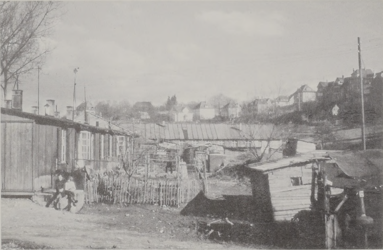
Ein weiteres Barackenlager stand in der Verlängerung der Bleichwiese (heute: Annonay-Anlage/Hallenbad).
