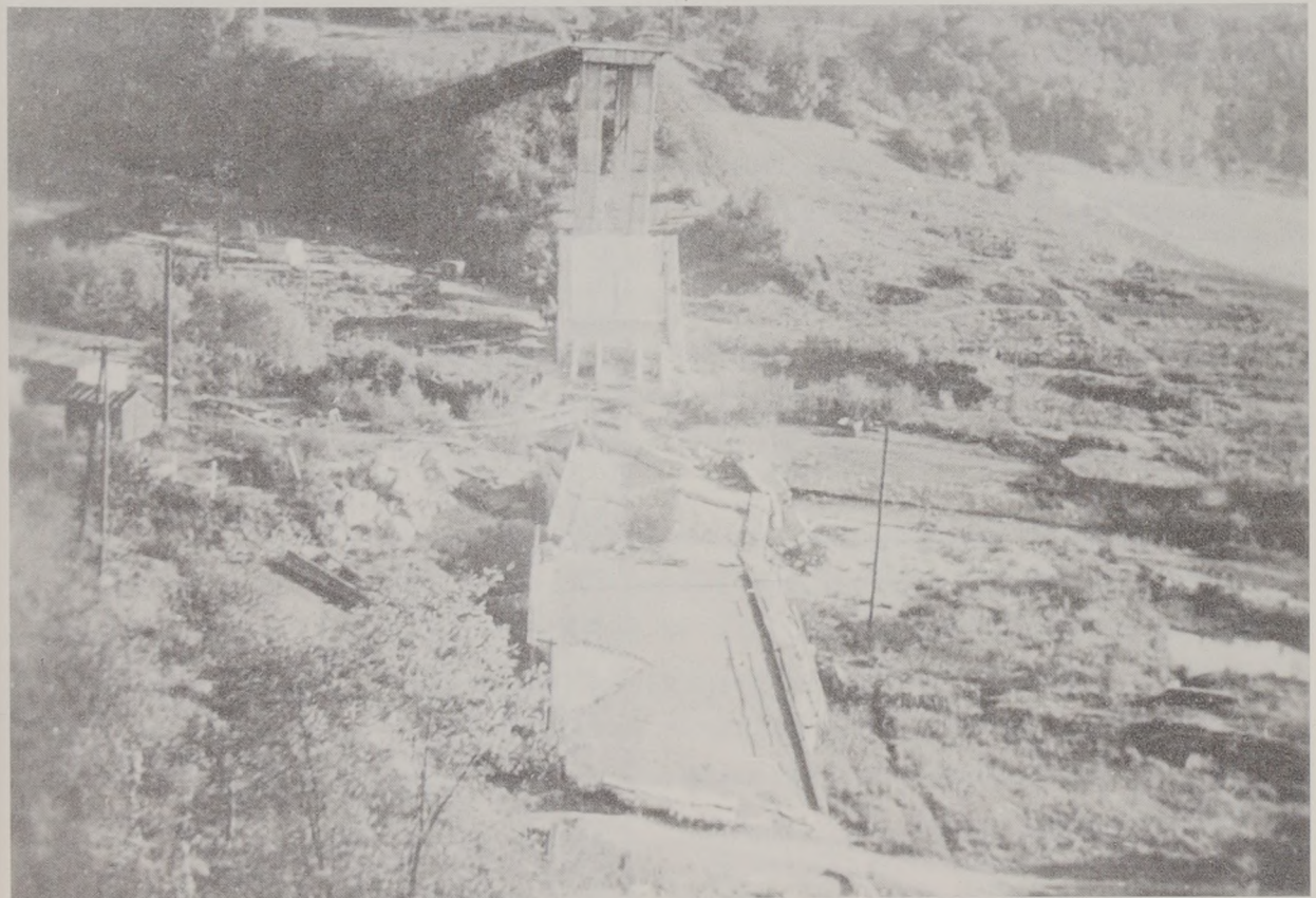
Auch das erst im Jahr 1938 fertig gestellte Murrtaal-Viadukt fiel den Sprengungen der Wehrmacht zum Opfer. Dies hatte zur Folge, dass die amerikanischen Truppen auf ihrem Vormarsch Richtung Stuttgart durch die Innenstadt Backnangs fahren mussten.
