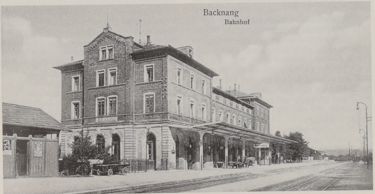
Im 1877/78 erbauten Backnanger Bahnhof arbeitete Hermann Sinn zwischen 1904 und 1910.
