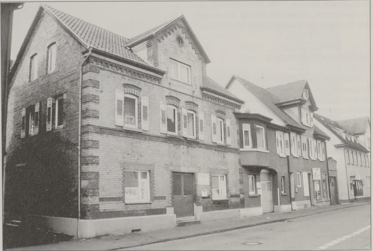
Die Gebäude Wilhelmstraße 11 und 13 im heutigen Zustand.
