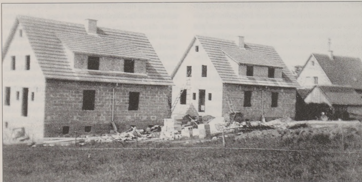
Siedlungshäuser in Unterbrüden im Rohbau 1951 (jeweils ein Doppelhaus).
