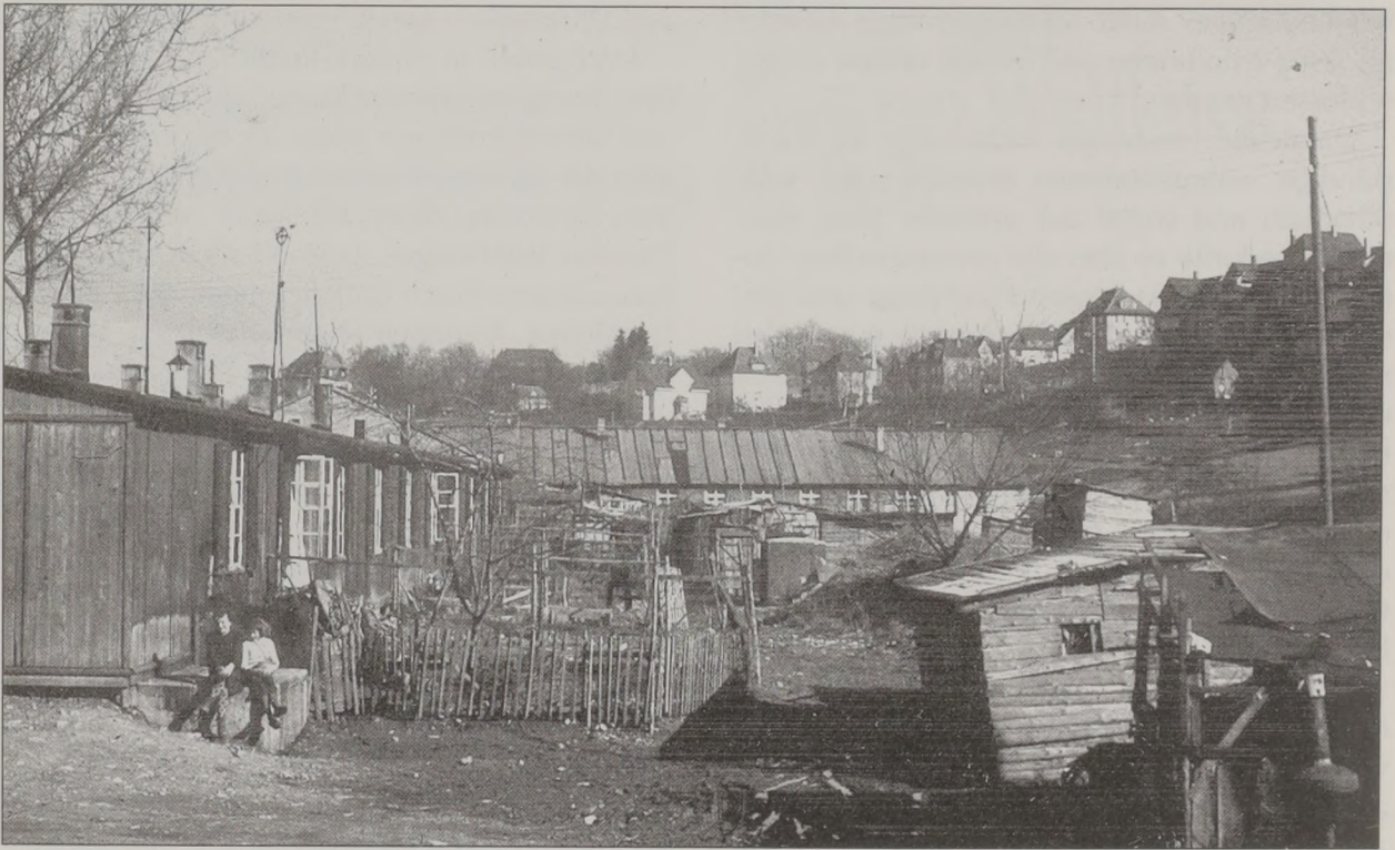
Flüchtlingsbarackenlager in der Verlängerung der Backnanger Bleichwiese.
