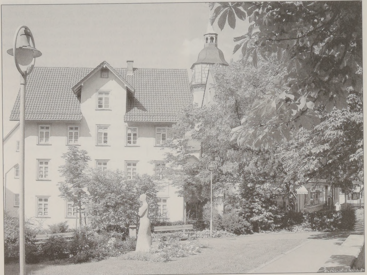
Das idyllisch am Schillerplatz gelegene Domizil des Mieterbundes (Am Schillerplatz 3).
