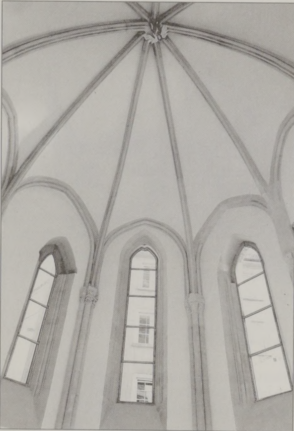
Blick in den restaurierten Gotischen Chor der ehemaligen Michaelskirche aus dem 13. Jh. (Aufnahme von 2004).
