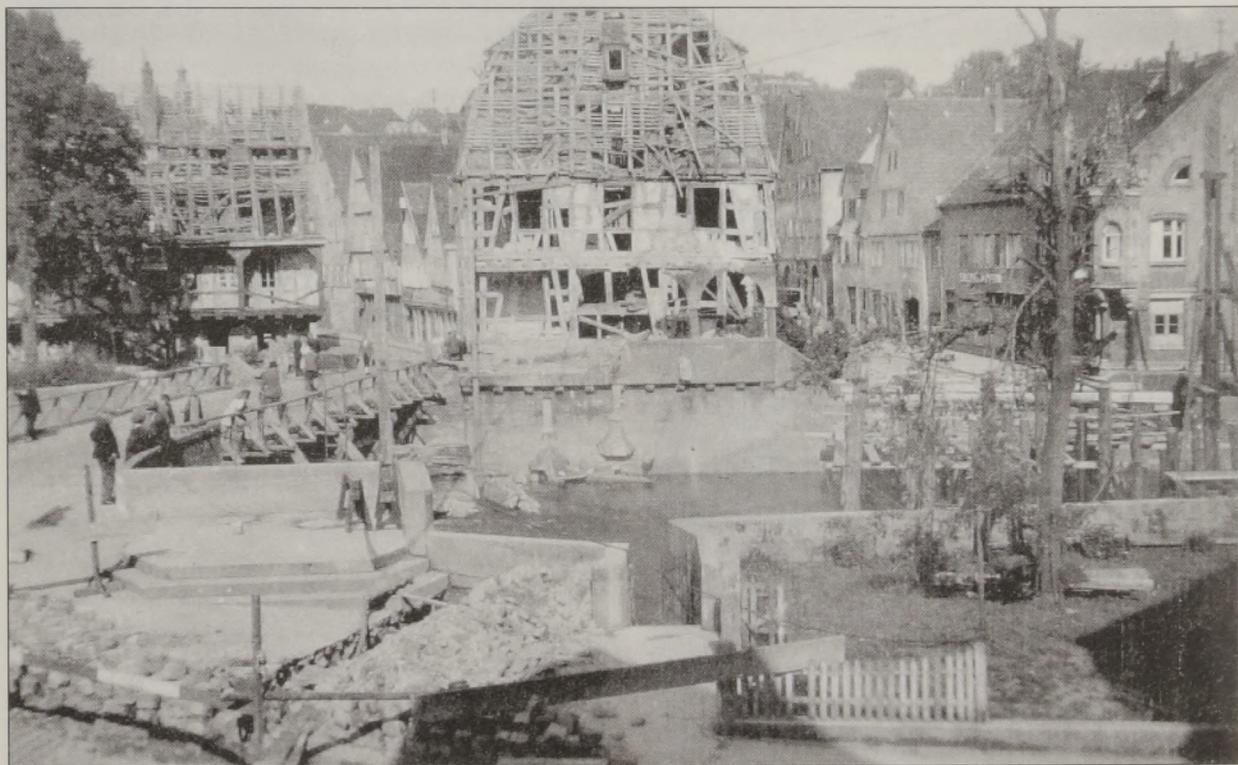
Blick auf die bei der Sprengung der Aspacher Brücke am 20. April 1945 beschädigten Gebäude mit dem ehemaligen Gasthaus „Krone“. Am linken Bildrand die an Stelle der zerstörten Aspacher Brücke erstellte Notbrücke.
