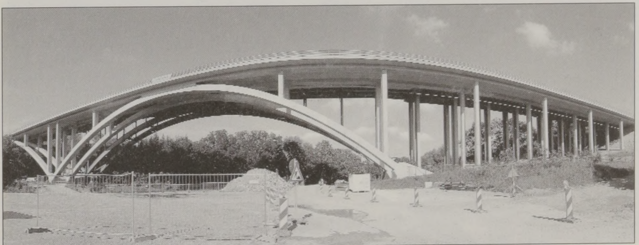
Nach zweijähriger Bauzeit kann das neue Murrtaiviadukt eingeweiht werden.
