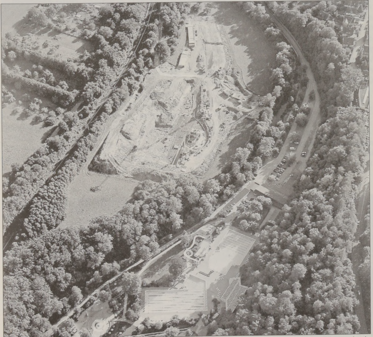
Größte Backnanger Baustelle aller Zeiten: Beim Freibad entsteht das neue Familien- und Sportbad.
