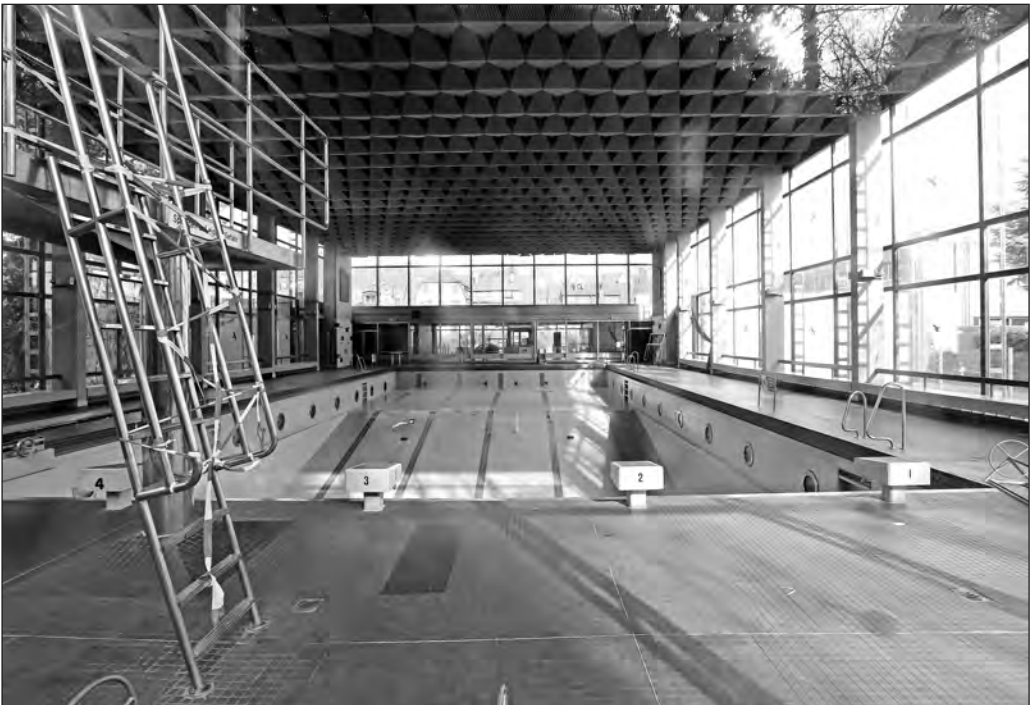
Blick ins „alte“ Hallenbad, dessen Abbruch nun beschlossene Sache ist.
