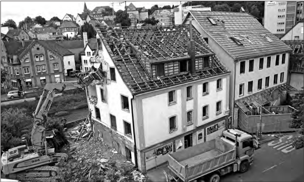
Drei historische Häuser in der Gerberstraße müssen einem Neubau weichen.
