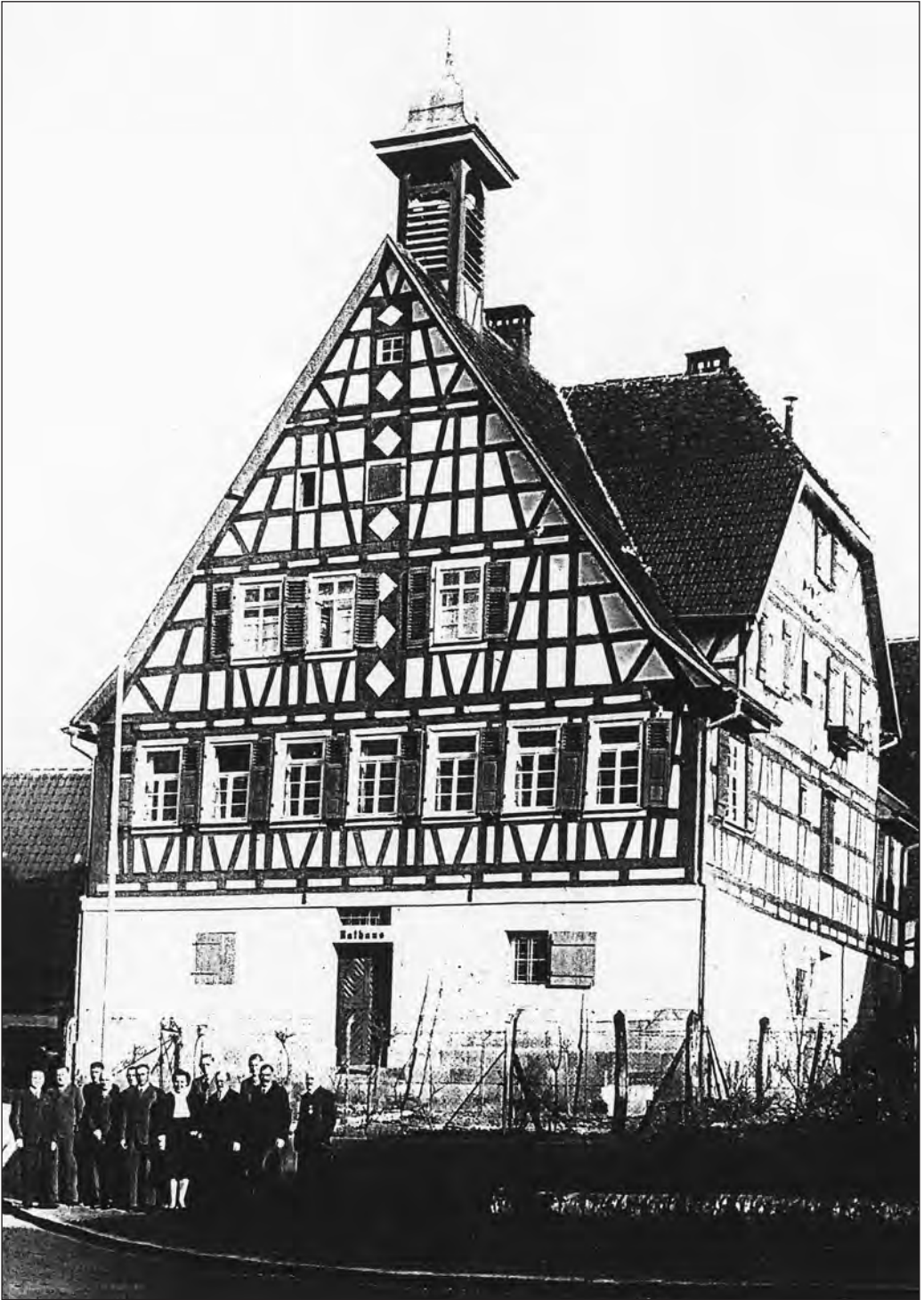
Auch heute noch eines der schönsten Steinbacher Gebäude: Das ehemalige Rat- und Schulhaus.
