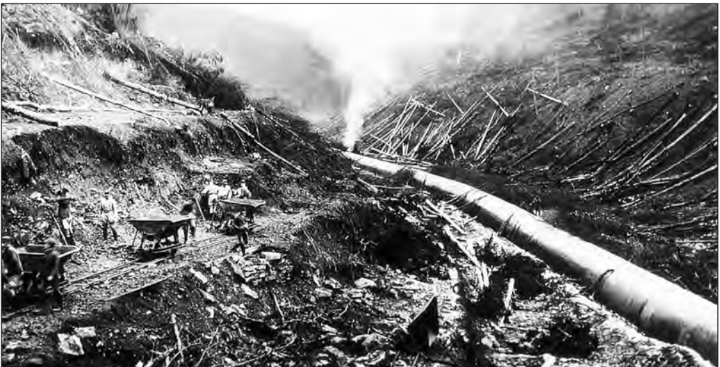
Bau der Zuleitung zur Kläranlage in Neuschöntal Anfang der 1930er-Jahre.
