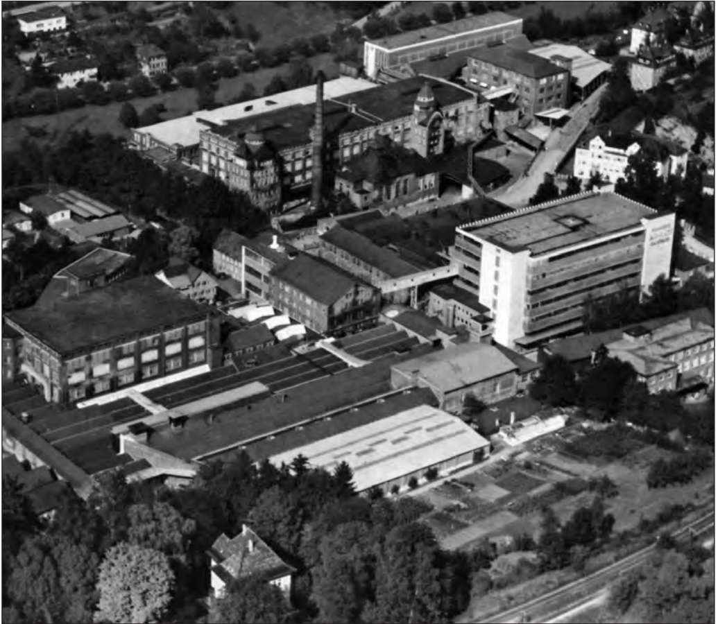
Die Luftaufnahme aus den 1960er-Jahren zeigt, wie eng bebaut das Werksareal der Spinnerei Adolff inzwischen war.
