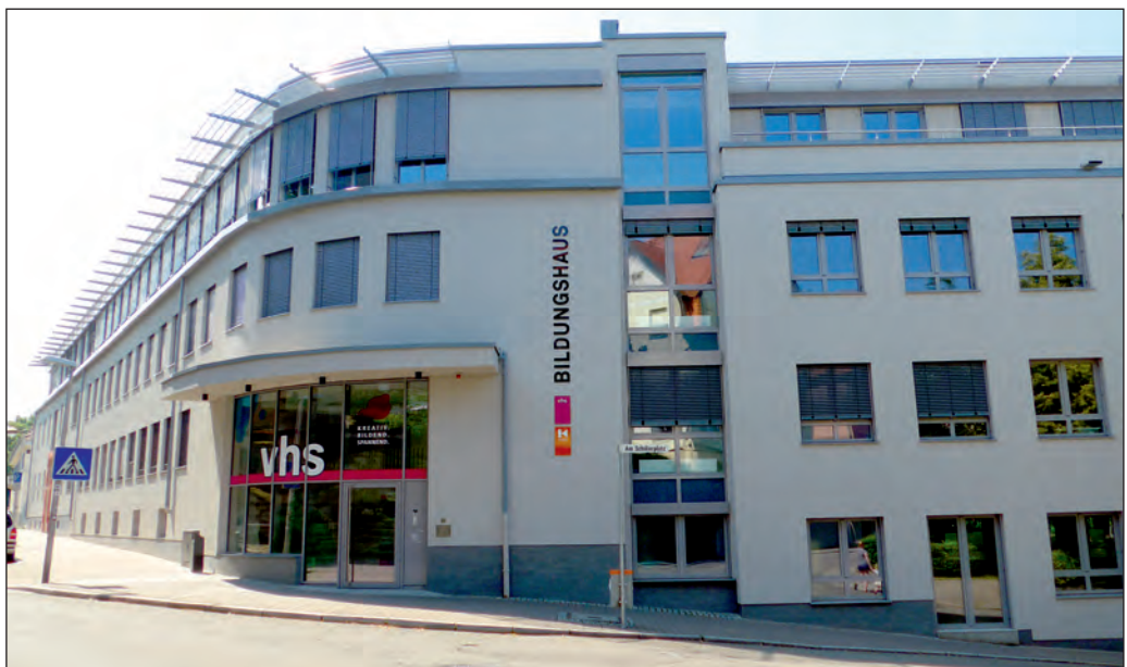
Der Komplex nach dem Umbau zum Bildungshaus. Man erkennt noch die markante Rundung der ehemaligen Oberamtssparkasse.
