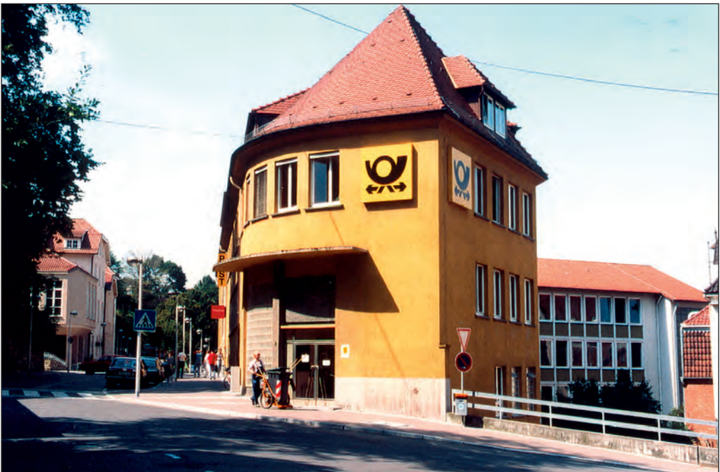
Blick auf das Postamt im ehemaligen Amtshaus mit Erweiterungsbau im rückwärtigen Bereich (Aufnahme von 1988).
