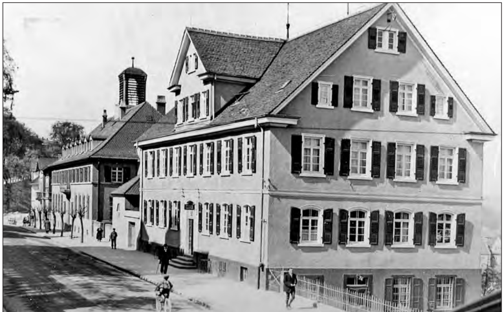
Die Bahnhofstraße im Jahr 1925 mit dem neuen Postamt (hinten) und dem nun als Amtshaus genutzten ehemaligen Bezirkskrankenhaus (vorne).
